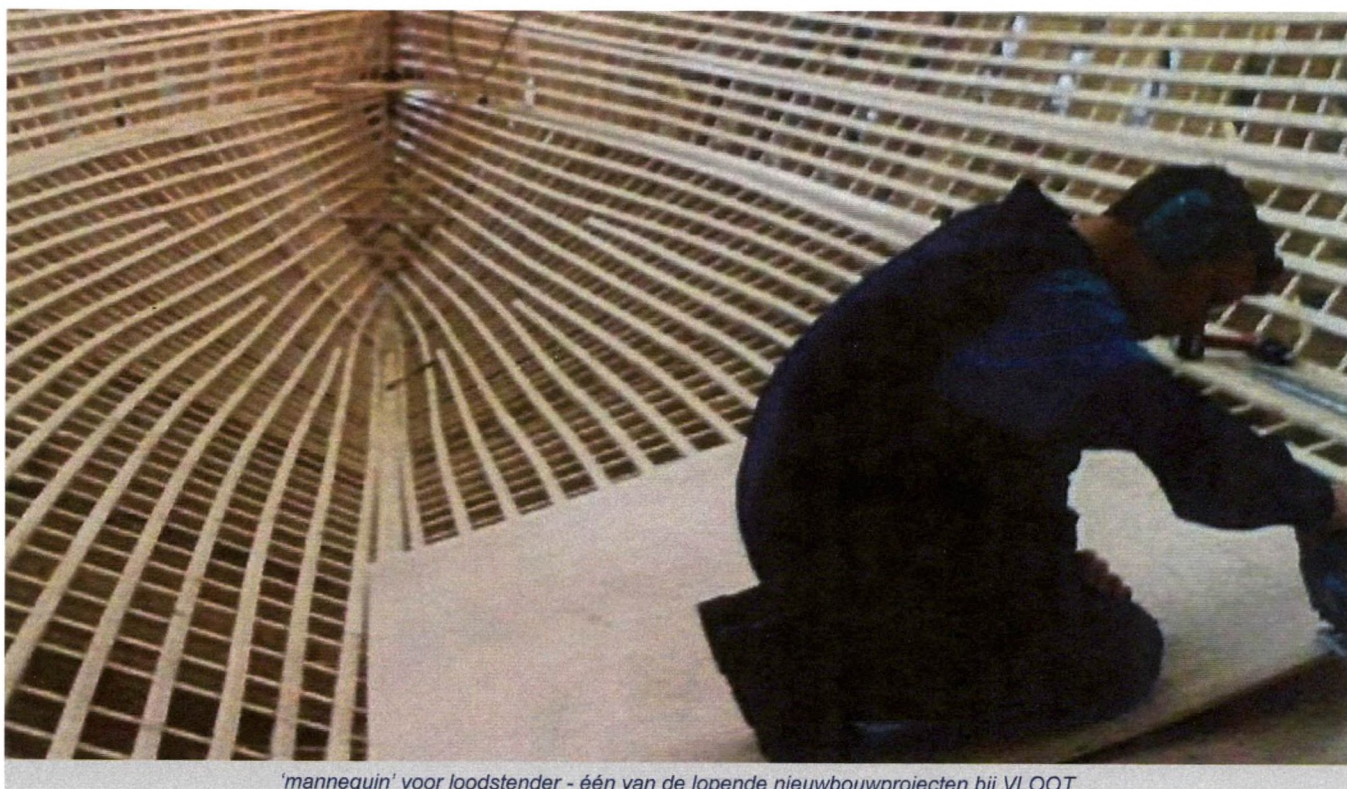
'mannequin' voor loodstender - één van de lopende nieuwbouwprojecten bij VLOOT
