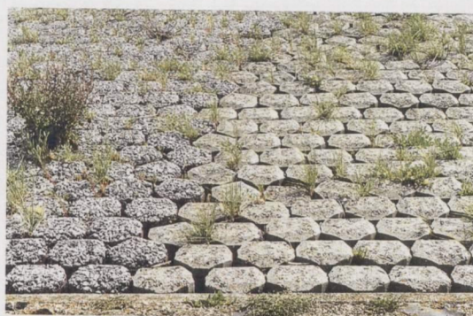
Foto 3: Betonzuilen met en zonder ecotoplaag (Pitpolygoonzuil)
