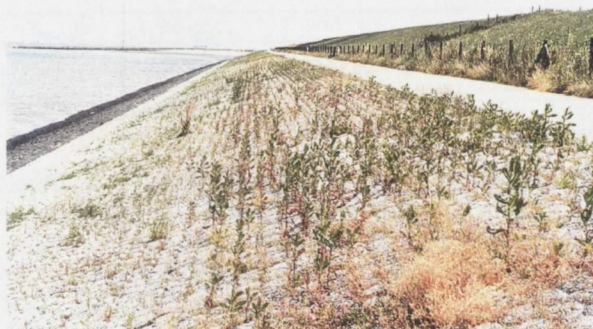
Foto 7: Overzicht dijktraject langs de Hoofdplaatpolder
