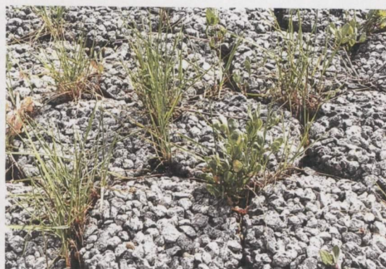
Foto 8: Betonzuil met ecotoplaag (Pitpolygoonzuil) en Gewone zoutmelde, Strandkweek en Spiesmelde
