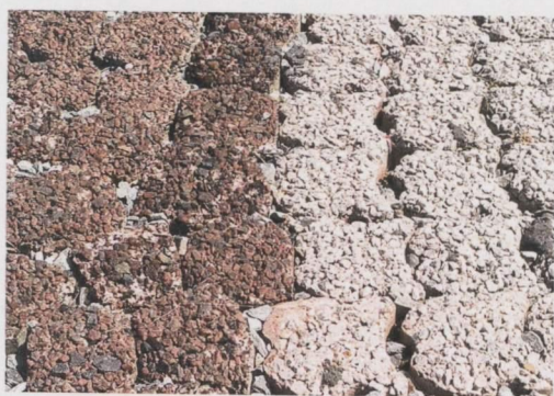
Foto 2: Betonzuilen met ecotoplaag (links Basalton, rechts Hydroblock)
