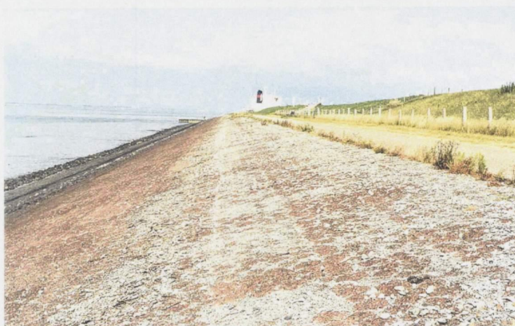
Foto 1: Dijktraject langs de Borsselepolder (Betonzuilen met ecotoplaag, Basalton)
