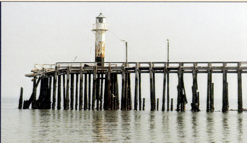
STAKETSELS KRIJGEN HET HARD TE VERDUREN
