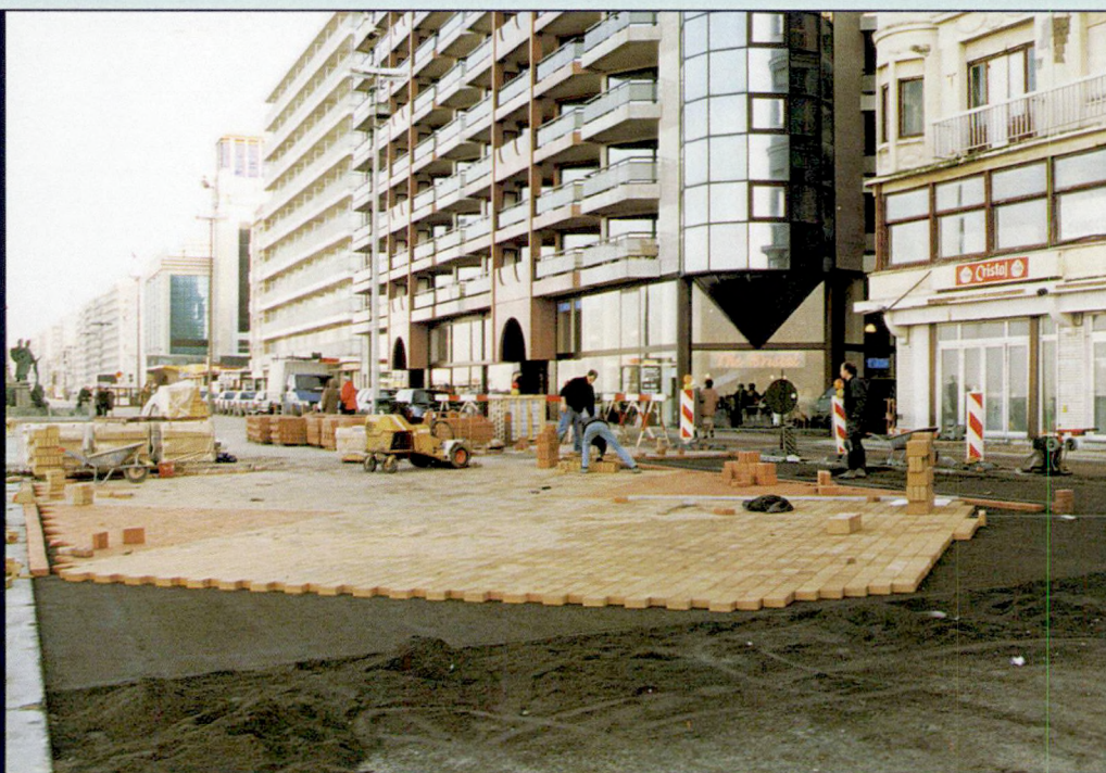
BLANKENBERGE: AANPAK VAN DE ZEEDIJKBEVLOERING
