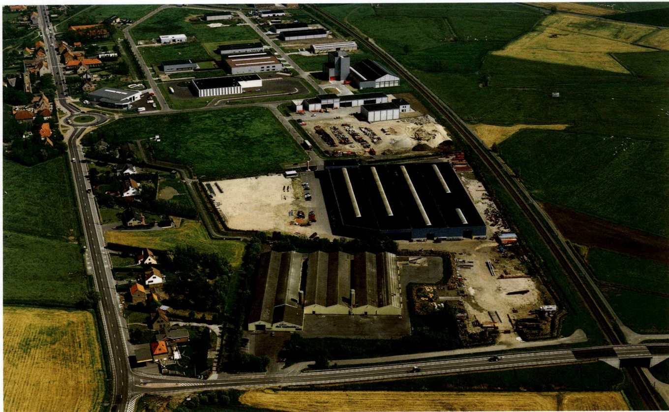
Bedrijventerrein Diksmuide. Bron: wvi.
