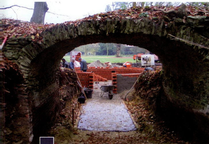
De nieuwe vloermuiskelder in Bulskampveld werd gebouwd naar het model van een ijskelder.
