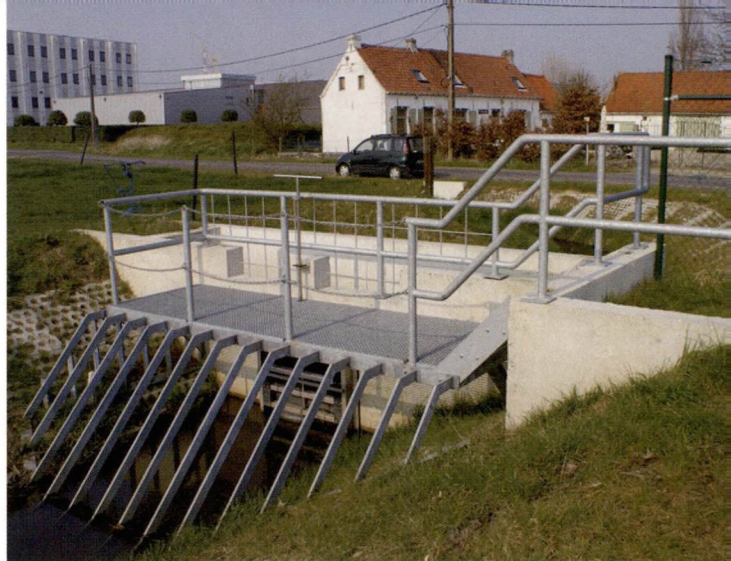
Het bufferbekken aan de Mannebeek in Waregem
