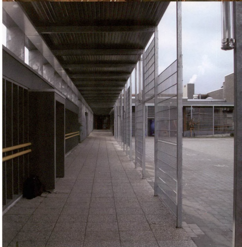
(b.) In het PTI, campus Graaf Karel de Goedelaan, werd de polyvalente ruimte uitgerust met passende verlichting, geluidsabsorptie en audiovisuele apparatuur.
