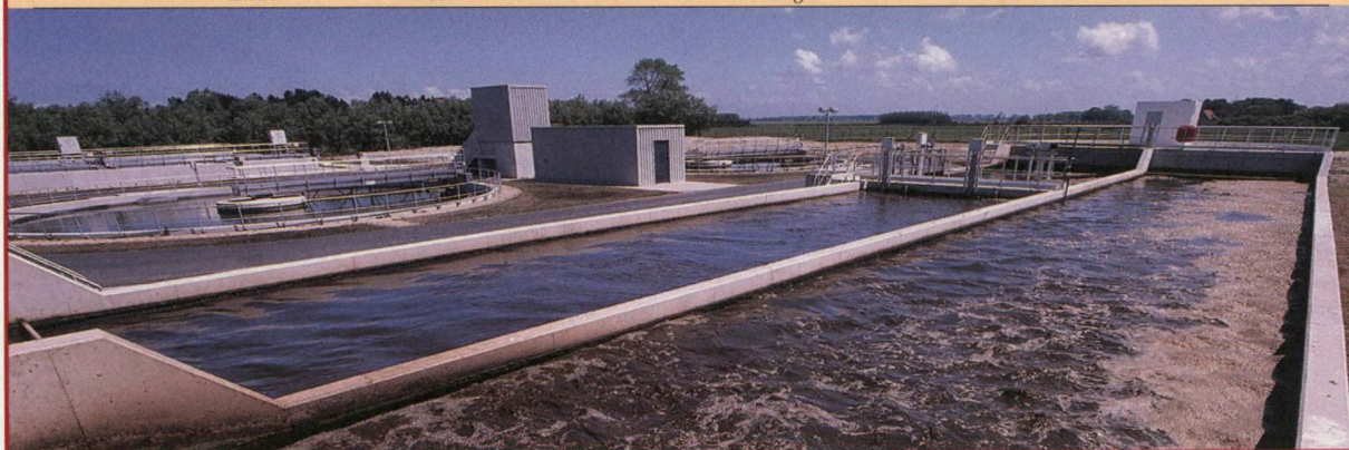
RWZI KNOKE (NIEUW GEDEELTE) - KNOKE
