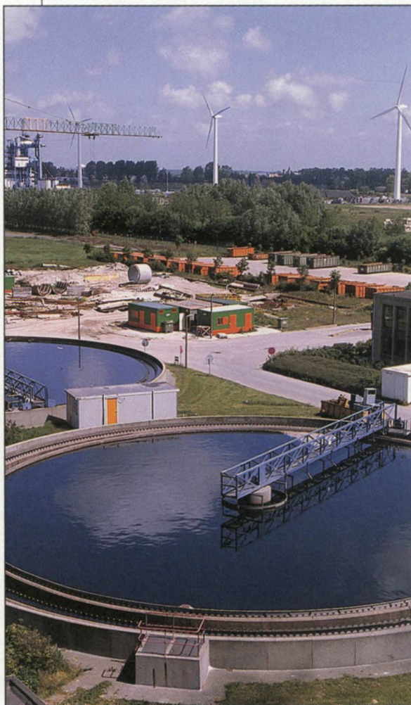
RWZI BRUGGE - BRUGGE
