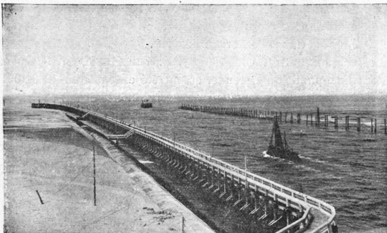
Estacade Ouest reconstruite et estacade Est en construction.
