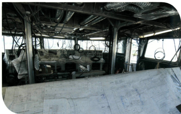
bekabelingswerken op de brug – © Franky Bruneel
