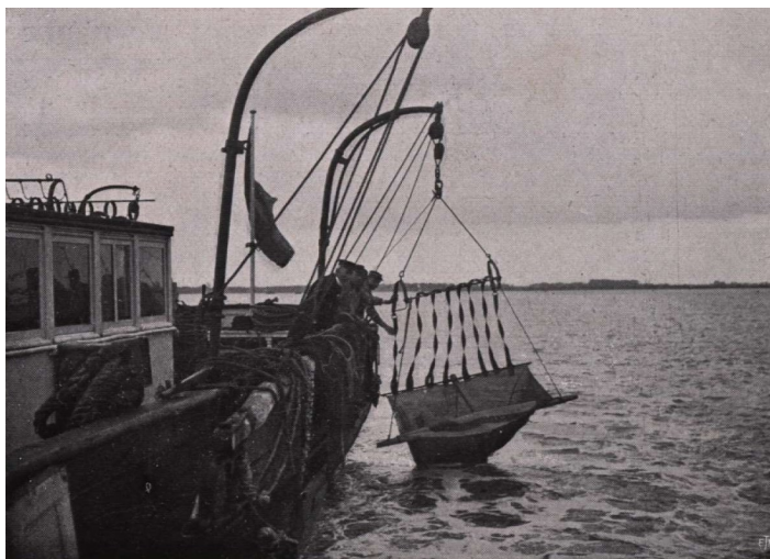
Een net met springveren, bestemd voor de vangst van semi-planktonische dieren op ongunstige bodems, wordt opgehaald door de Remorqueur n°1 ( Gilson, 1914 ).
