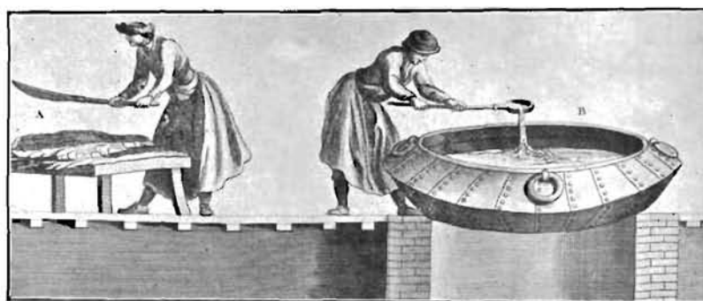
Fig. 19. Le lard qui a été levé de la baleine par grands morceaux est porté sur un établi en A et découpé en petits morceaux portés dans une grande chaudière B montée sur un fourneau en briques où on le fait cuire pour en extraire l'huile.
