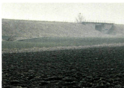
Fig. 6.5. In het vlakke polderland treft men bermen en dijken aan, die bij een doorbraak van de eerste kustverdedigingslijn zouden fungeren als waterkering. Hier de berm van de vroegere spoorlijn Oostende-Torhout, die evenwel toch geen ononderbroken verdedigingslijn vormt.
