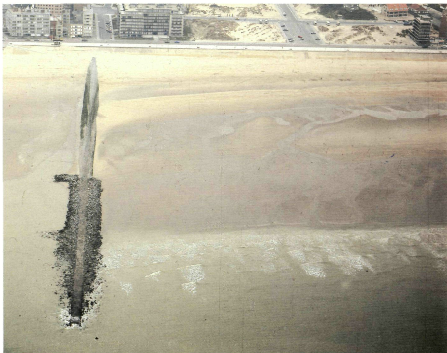
Fig. 4.6. Het strandhoofd nr. 10 te Koksijde werd uitgebouwd in de periode 1987-1988. Men merkt duidelijk de verbreding van het strand naar het strandhoofd toe.
