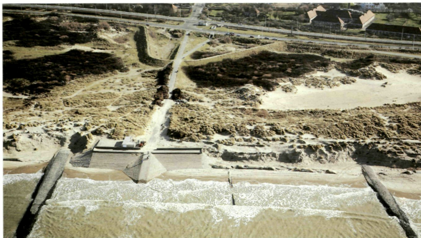
Fig. 4.7. De strandtoegang "Hippodroom" te Bredene. Op het droogstrand zijn Longardbuizen aanwezig. Op de achtergrond, voor de Koninklijke Baan, merkt men de lusvorm van de wachtdijk.
