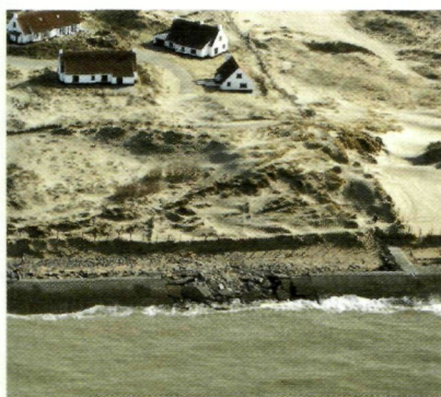
Fig. 4.5. De Panne, ter hoogte van het vissersdorp. Beschadiging aan de versterkte duinvoet trad op als gevolg van de zware stormen van begin 1990.
