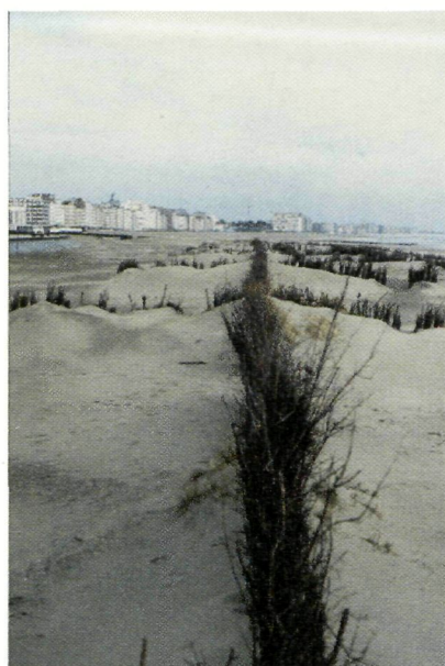
Fig. 3.3. Hagen in rijshout en gekapteerd eolisch zand op het strand te Knokke-Zoute.
