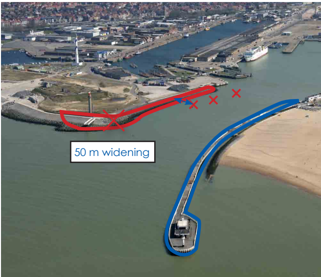
widening Halve Maandijk
