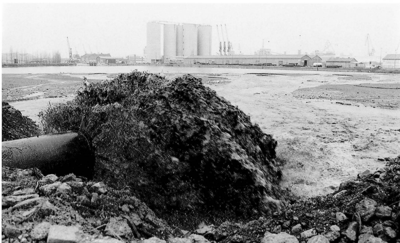
Foto 23. — De opvulling van het Oude Schuuldok met een detail van de spuimond.
