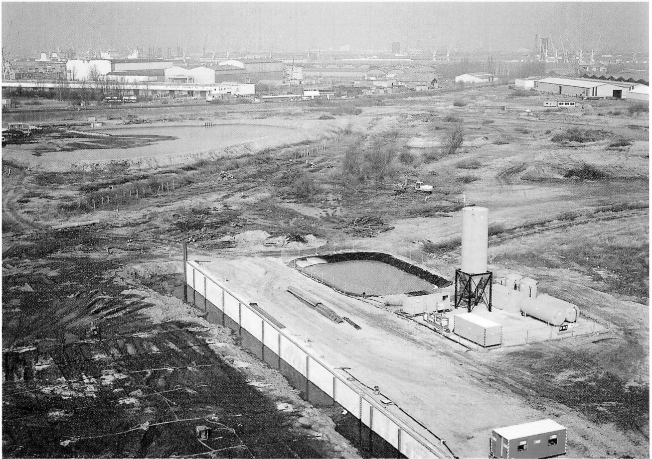
Foto 9. — Op de voorgrond de mobiele waterzuiveringsinstallatie en een deel van de af te graven gronden van kaai 57. Op de achtergrond de gronden ter hoogte van het geplande wacht dok voor lichters.
