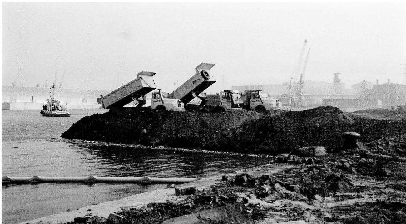
Foto 24. — De eerste fase in de opvulling van het Eerste Havendok. Het Eerste Havendok wordt afgesloten van het Albertdok d.m.v. een wand die bestaat uit niet verontreinigd materiaal.
