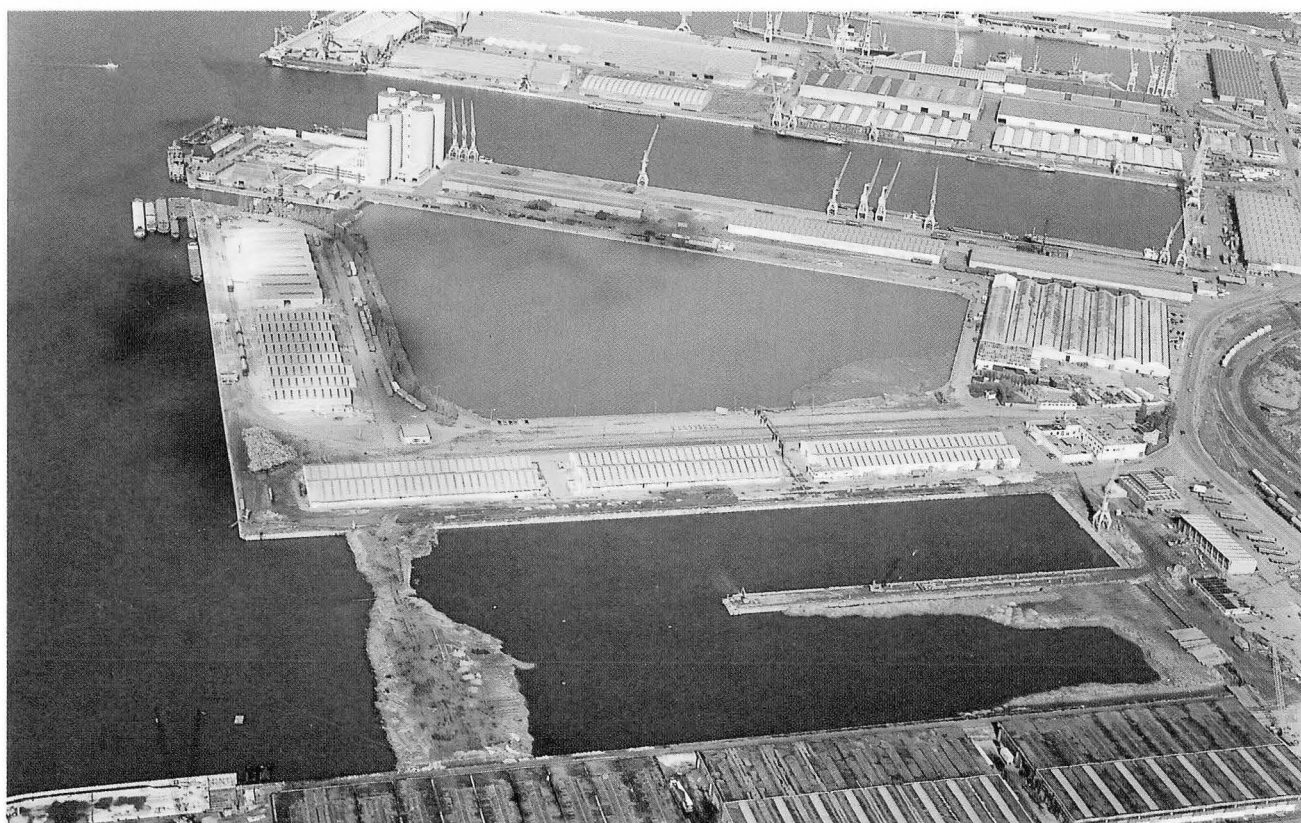
Foto 21. — De eerste fase in de opvulling van het Eerste Havendok is voltooid. Het Eerste Havendok is afgesloten van het Albertdok. Op de achtergrond het Oude Schuuldok voor Lichters dat eveneens dient opgevuld te worden.
