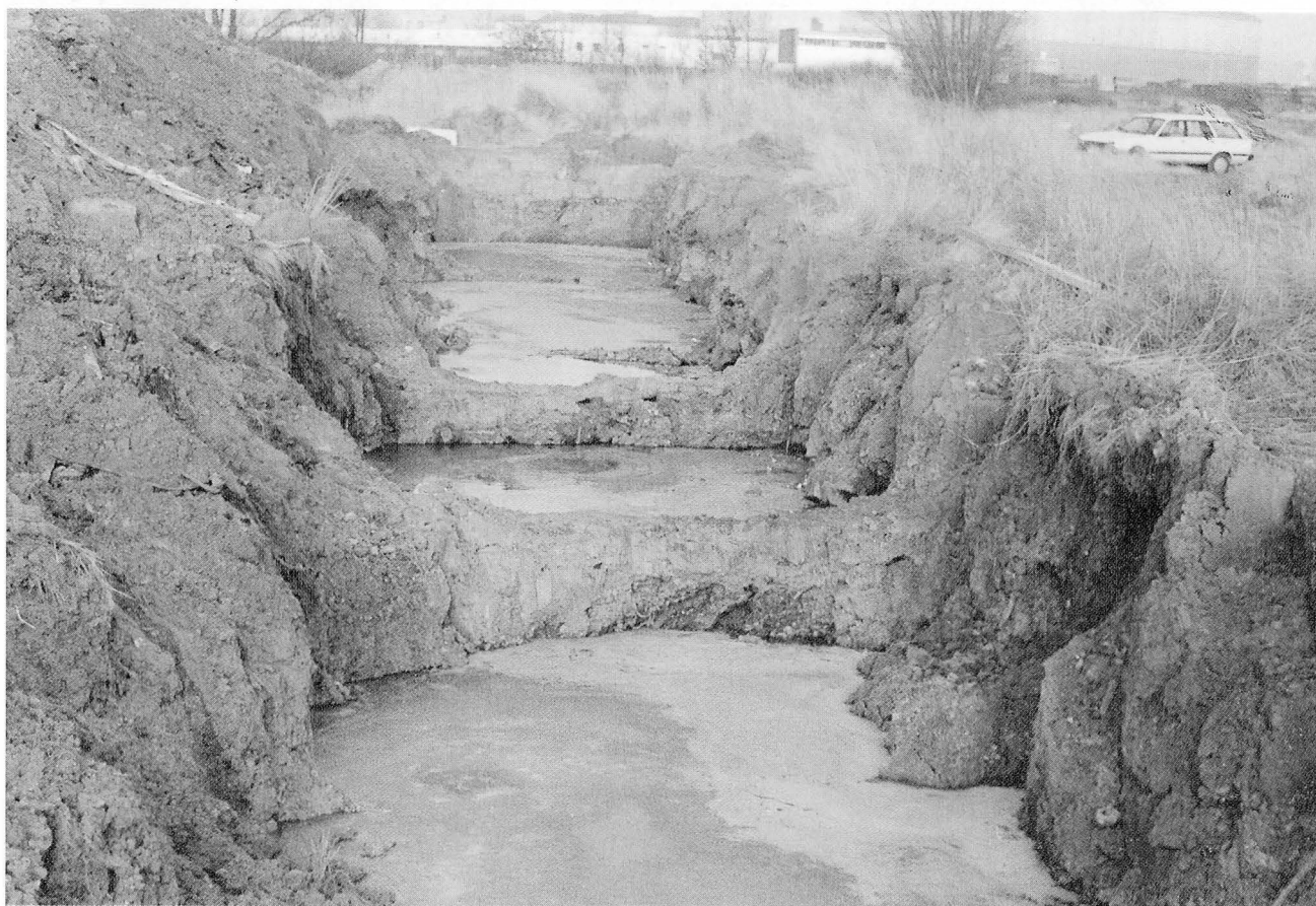
Foto 3. — Eén van de verkenningssleuven die gegraven werden om een duidelijk beeld van de ondergrond te bekomen. Sleuf 1.
