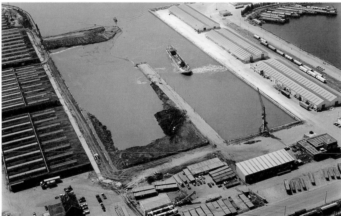
Foto 20. — Per schip worden de gronden, afgegraven ter hoogte van kaai 57, aangevoerd voor de opvulling van het Eerste Havendok.
