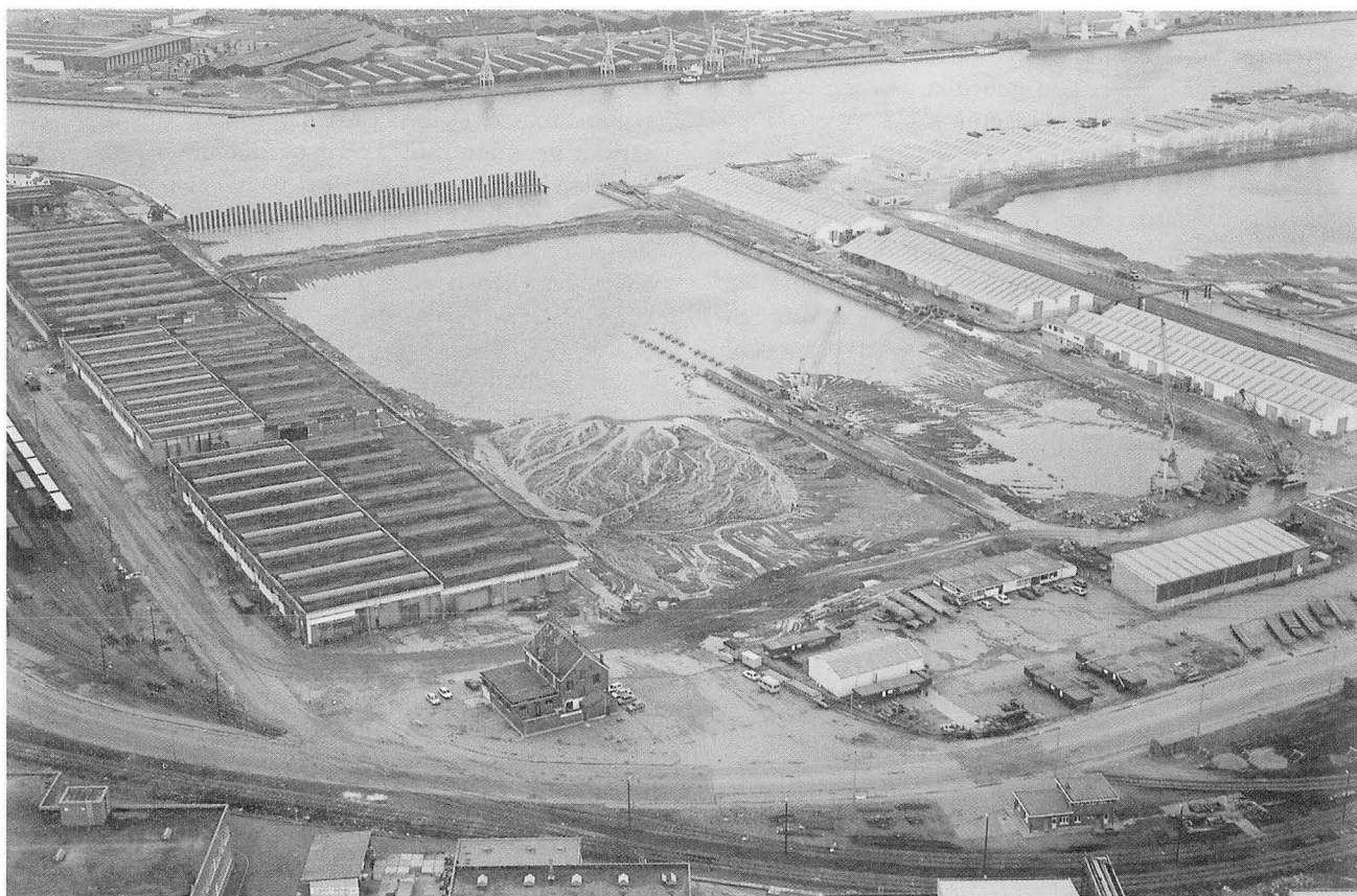
Foto 22. — Hier heeft de aanvoer van het materiaal via de persleiding een aanvang genomen.
