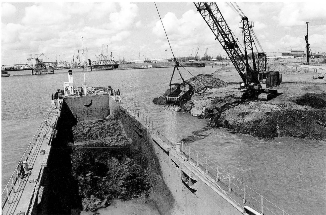
Foto 18. — De uitgraving en het vervoer van de gronden ter hoogte van kaai 57.
