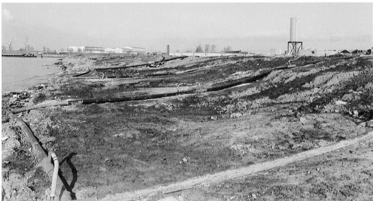
Foto 8. — Via de ondiepe bemalingsfilters werd er water uit het Amerikadok opgepompt.
