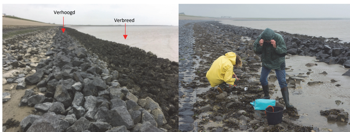
Figuur A2. Voorbeeld van het verbreide en verhoogde stuk stortberm (links) en een controle transect op de stortberm. Op de behandelde stortberm staat het verhoogde en verbreide stuk van de stortberm aangegeven.
