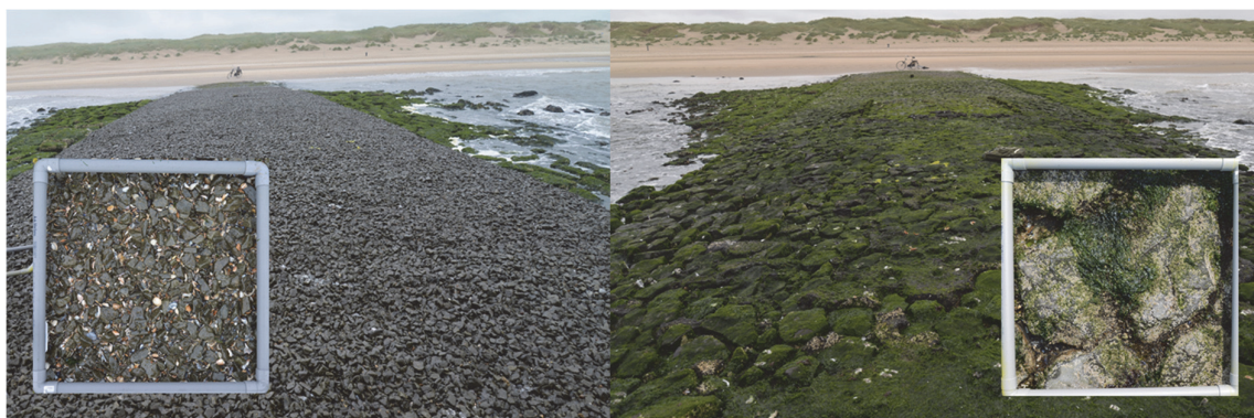
Figuur A1. Voorbeeld van een Elastocoast® strandhoofden (links) en een controle strandhoofd (rechts) met een bovenaanzicht. Foto's zijn genomen in 2013, toen de behandelde strandhoofden nog niet waren hersteld wat betreft aanwezige mossen.
