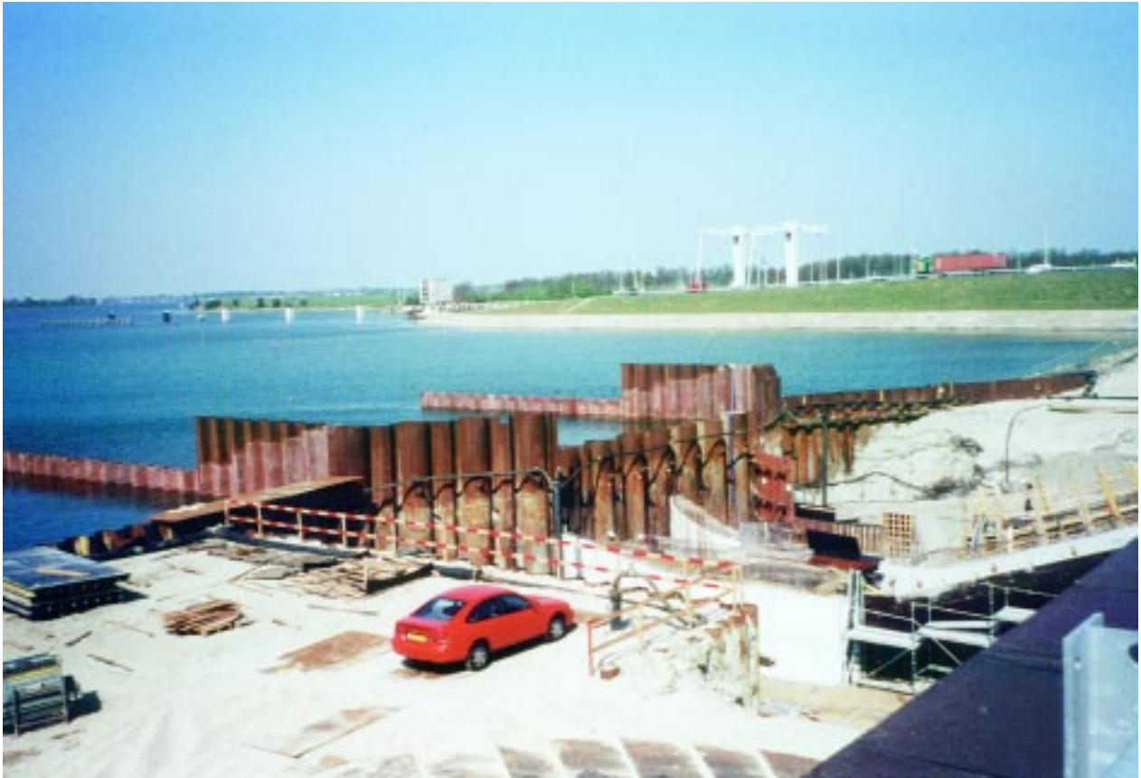
De aanleg van het doorlaatmiddel in de Zandkreekdijk.
