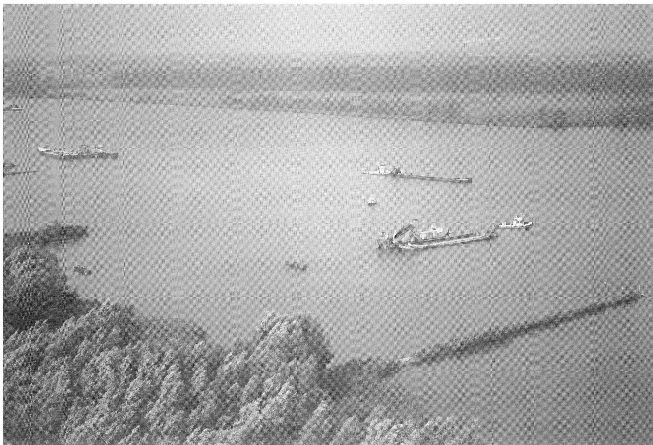
Fig. 2. — Baggervloot met ECODRAG aan het werk tijdens de saneringsoperatie in de Nieuwe Merwede.
