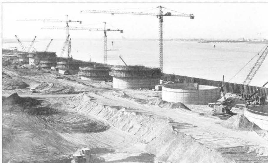
De bouwwerf van de containerkaai
