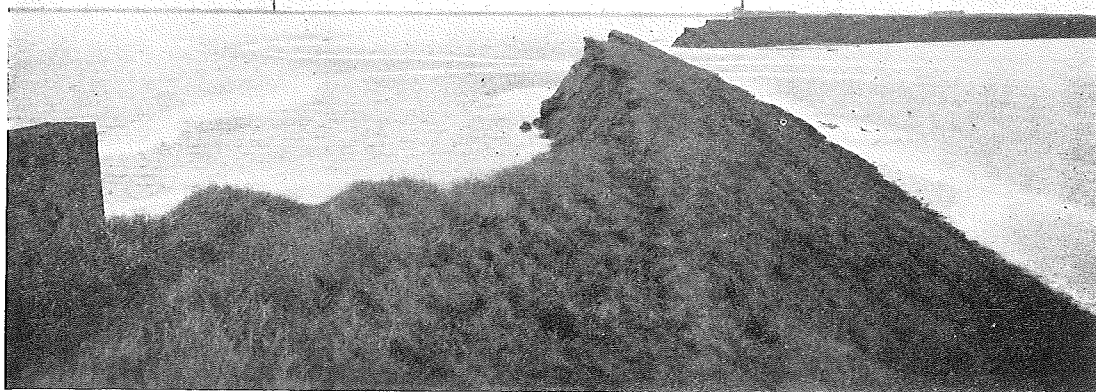
Fig. 47. Oever- en dijkval van 9 April 1943 aan den Wilhelminapolder (Zuid-Beveland). Rechts: de overstroomde polder.
