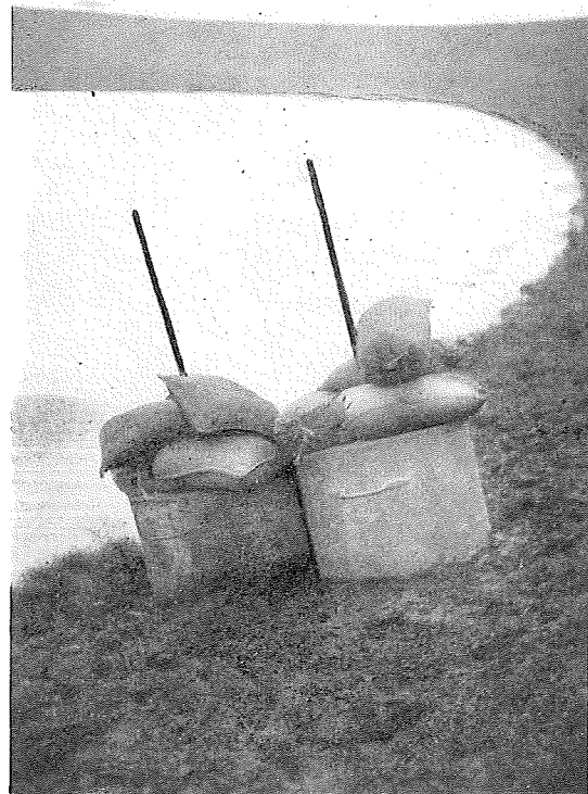
Fig. 164. Bedwingen van wellen met weltonnen.
