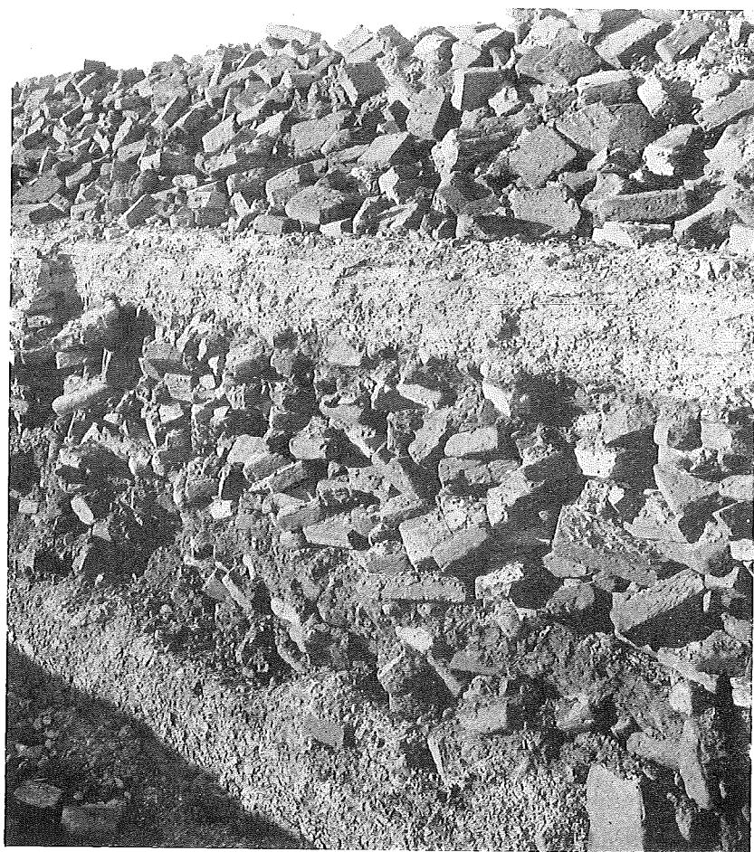
Fig. 60. De met puin verhoogde Zuiderzeedijk in 1916 ontgraven.
