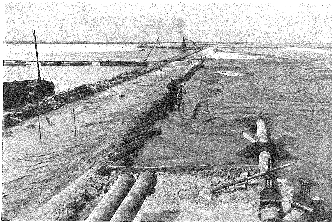
Fig. 87. Het opspuiten van den N.O.polderdijk tusschen Ramspol en Kadoelen van weeke baggergrond uit de vaargeulen.
