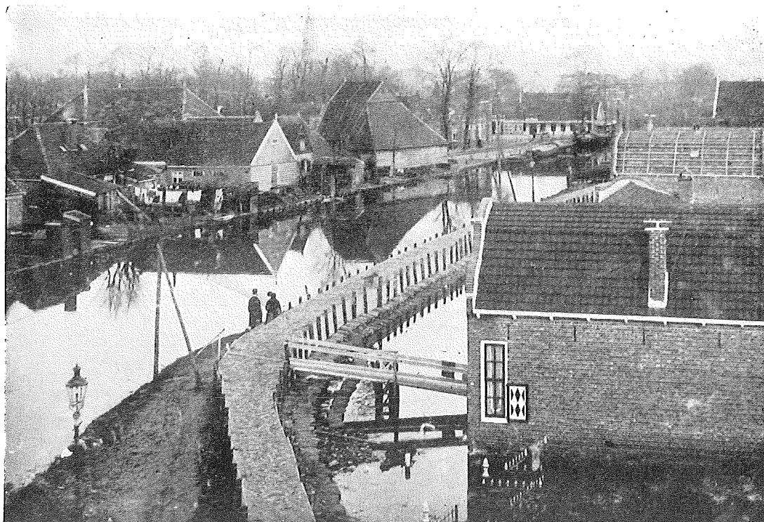
Fig. 195. Bekisting op een smallen weg. 1916.
