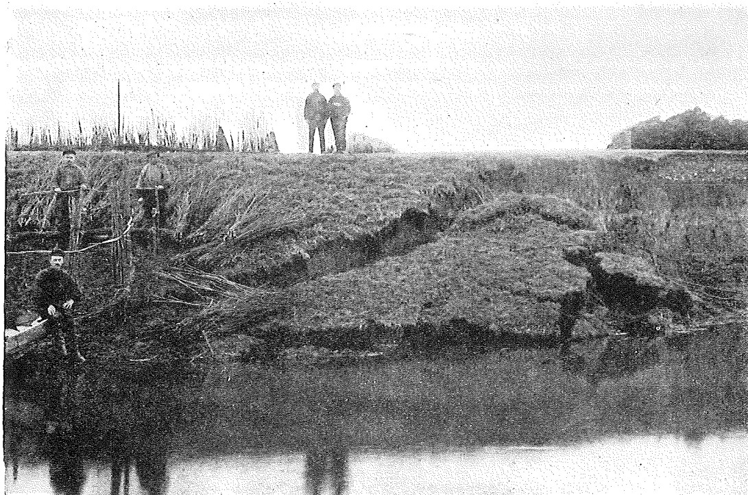
Fig. 63. Afschuiving van het binnenbeloop van den Waterlandschen Zeedijk Jan. 1916. Foto Rijkswaterstaat.
