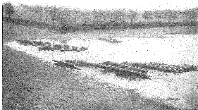
Fig. 167. Afdekking van wellen met rijshout en zakken zand.
