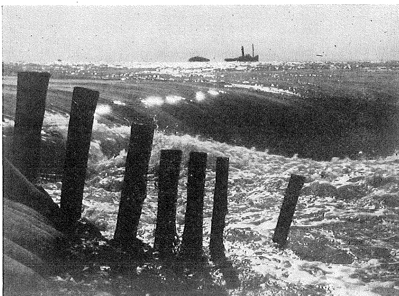
Fig. 126. Vloedstroom door het gat in den Nolledijk. Foto Jan Henning, Vlissingen.
