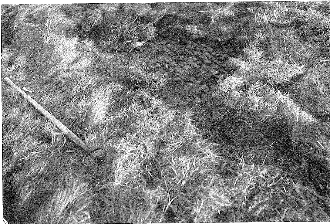
Fig. 41. Klinkerglooïing te Holwerd. De boven H. W. met gras overgroeide glooïing is over een klein gedeelte bloot gemaakt.
