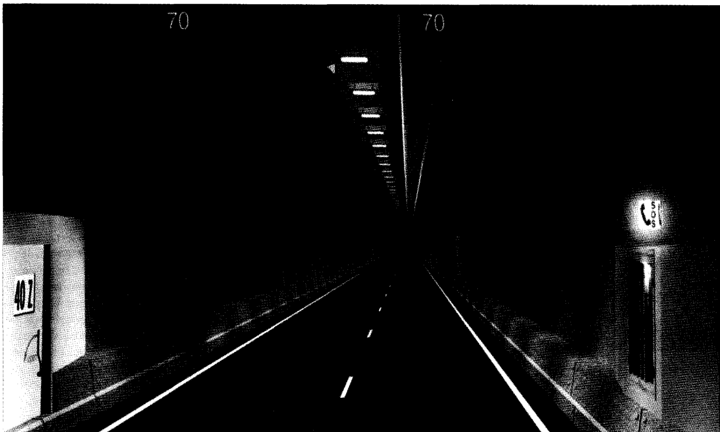
LINKS EEN DWARSVERBINDINGSDEUR EN RECHTS EEN HULPPOST IN DE TUNNEL
