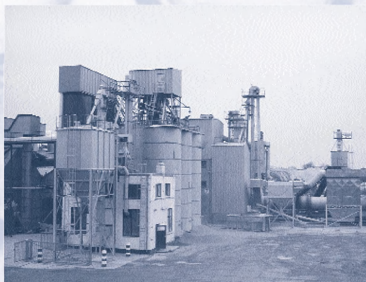
Deel van de schelpenverwerkingsfabriek te Yerseke
