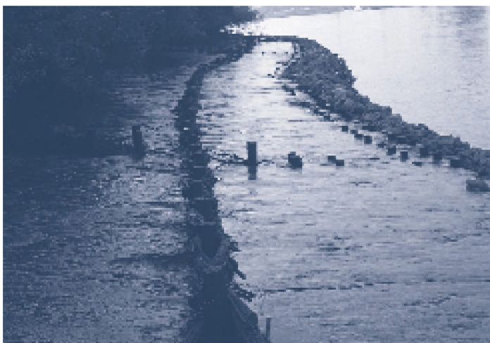
Alternatieve schorrandverdediging met terrasbouw in wilgenvlechtwerk gevlochten tussen perkoenpalen.
