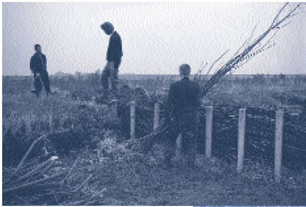
Boven: Aanleg rijshouten en wiepen-dammen in 1992
