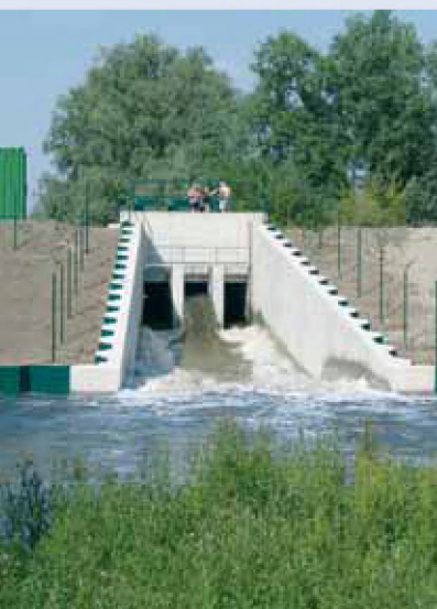
De sluis van dichtbij
