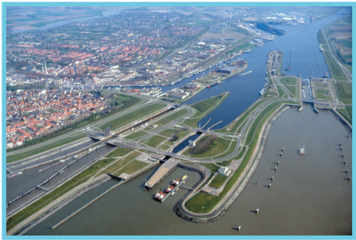
Figuur 1. Luchtfoto sluizencomplex Terneuzen. (Foto archief RIKZ)
