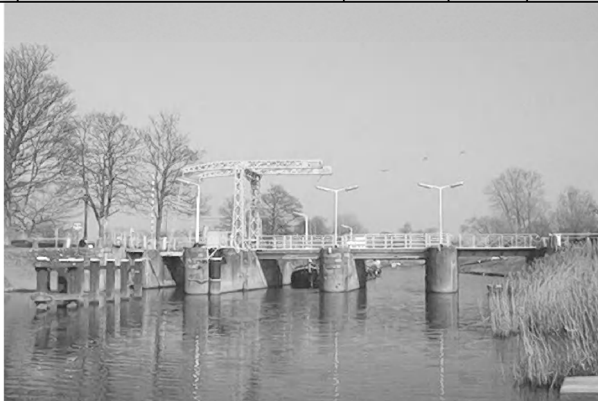
Oude stuw en sluis te Astene
