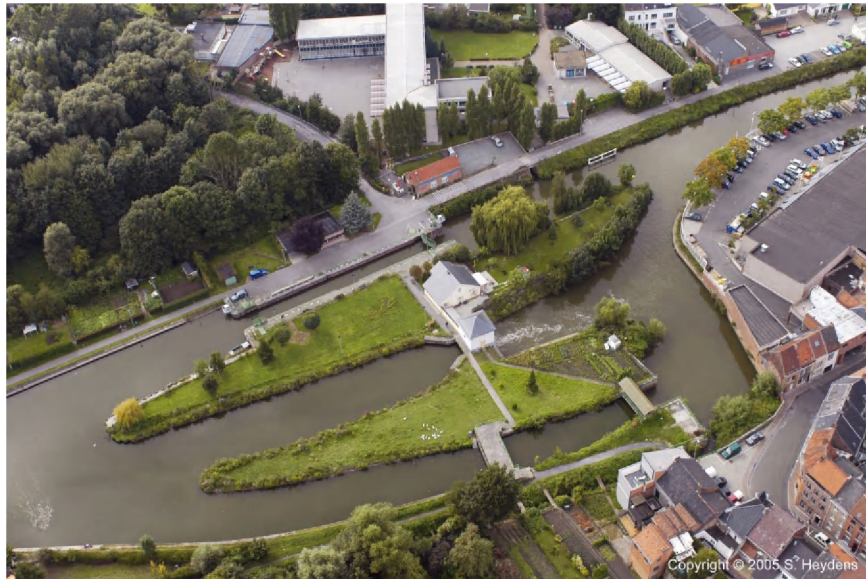
Bovenaanzicht stuwsluis Geraardsbergen
