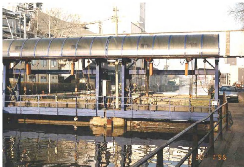
Vooraanzicht balkenstuw Aalst
