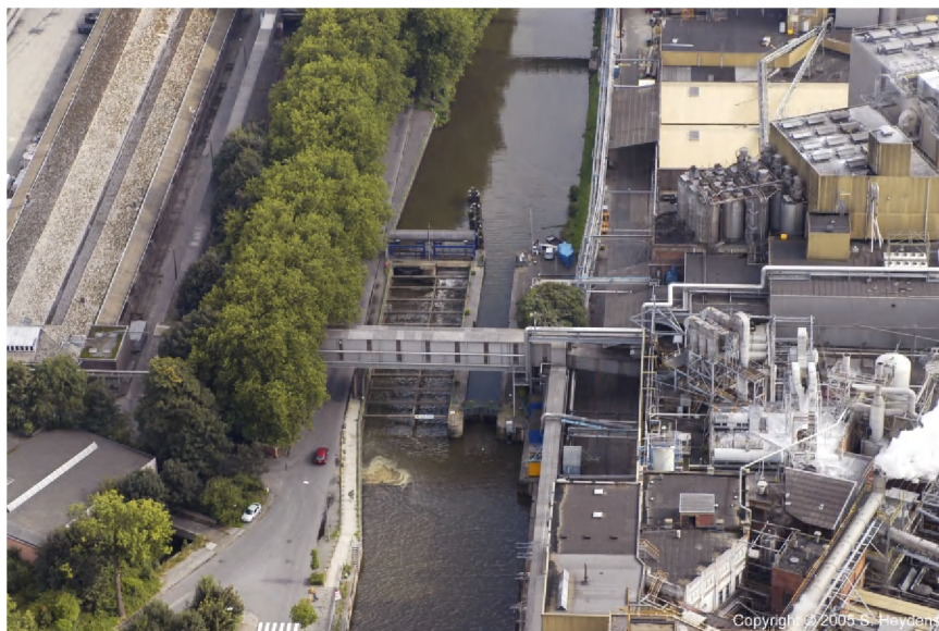
Bovenaanzicht stuwsluis Aalst
