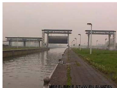
MERELBEKE STUWEN SLUIZEN
