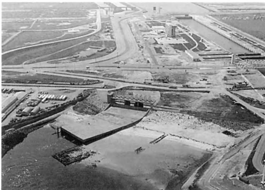
Uitwateringssluizen te Zeebrugge-Heist.
