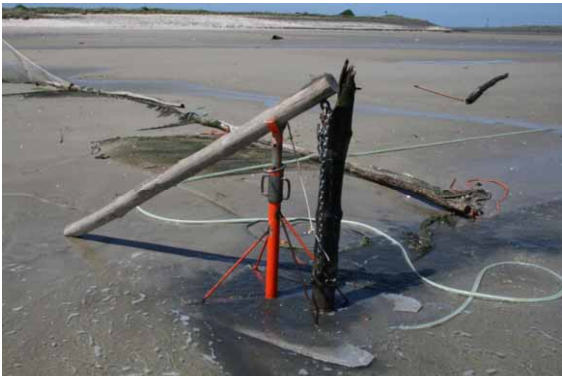
Afbeelding 8 Palen trekken met de bok
