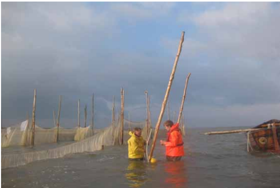
Foto 7. Palenspuiten bij laagwater. De motor van de palenspuit staat in de vlet.
