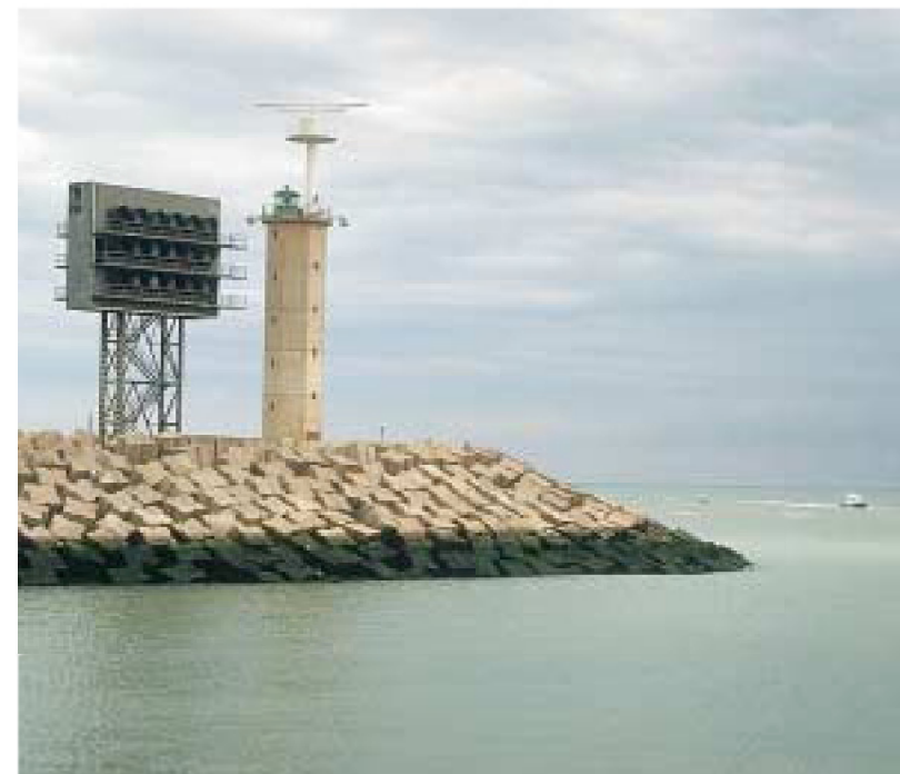
Eén van de radars van de Schelde Radar Keten
