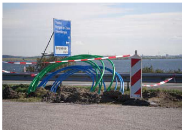
Glasvezelverbindingen transporteren beelden naar de verkeerscentrales
