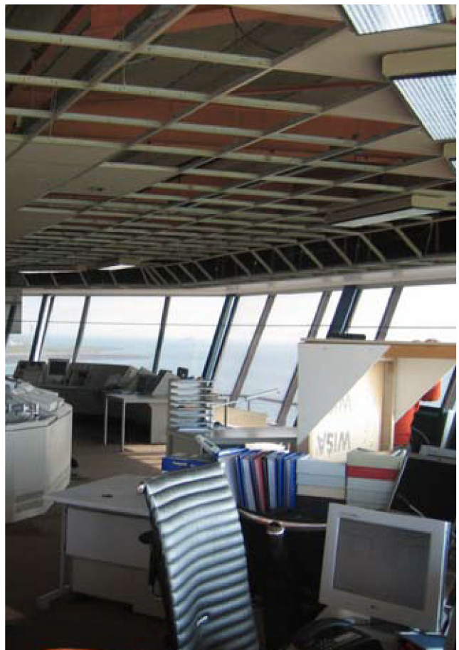
De Verkeerscentrale in Vlissingen krijgt een nieuw plafond
