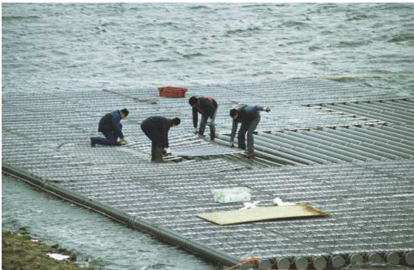
Aanleg van een drijvend vogeleiland
