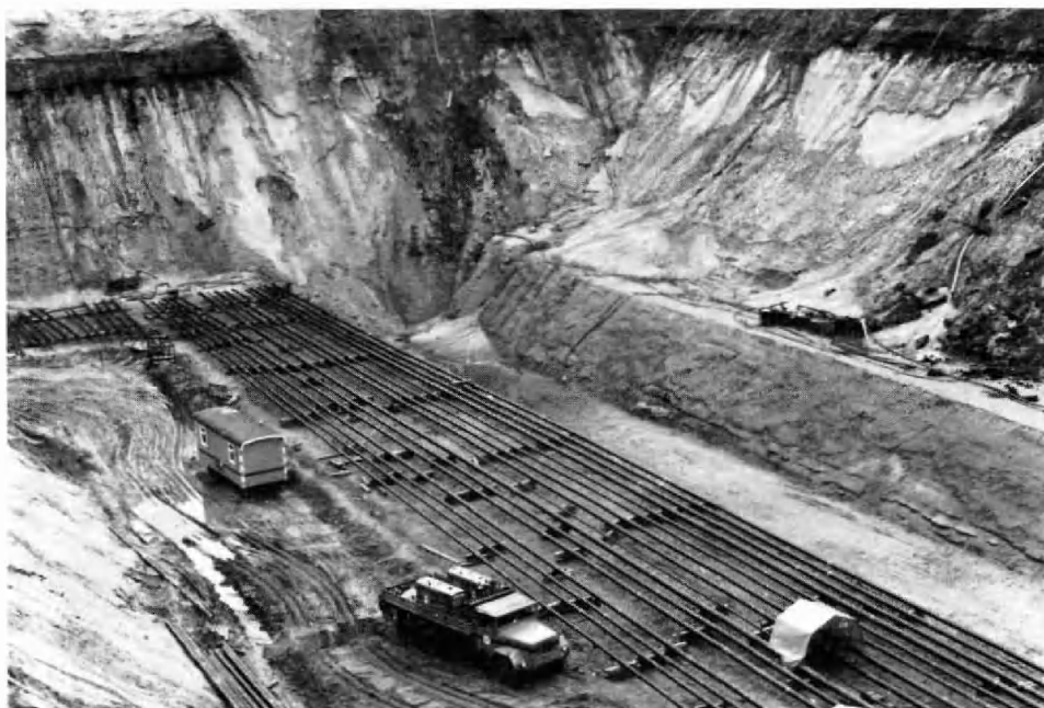
Figuur 8 : Omleggingswerken aan de leidingen.
