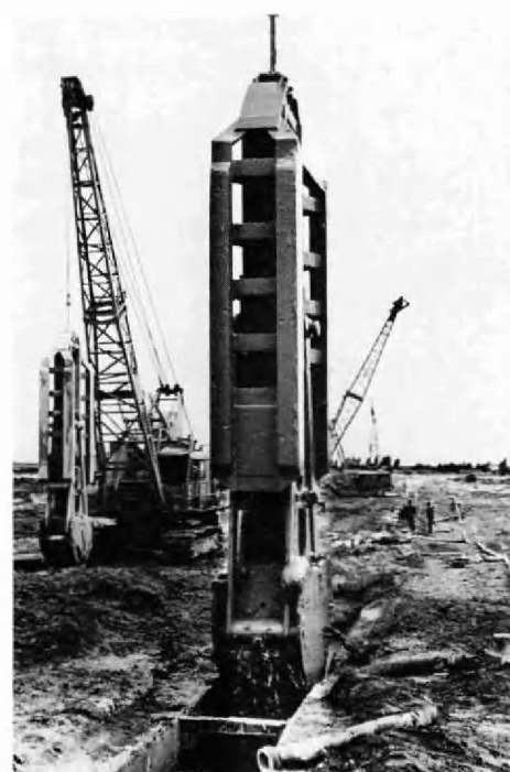
Figuur 7 : Het graven van de waterdichte betoniet-cementwand.
