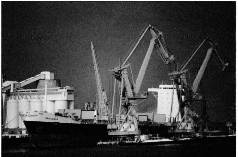
De stedelijke grijperkranen « Portunus » en « Titan » aan het werk bij de Solvay-terminal aan het 5de Havendok.
