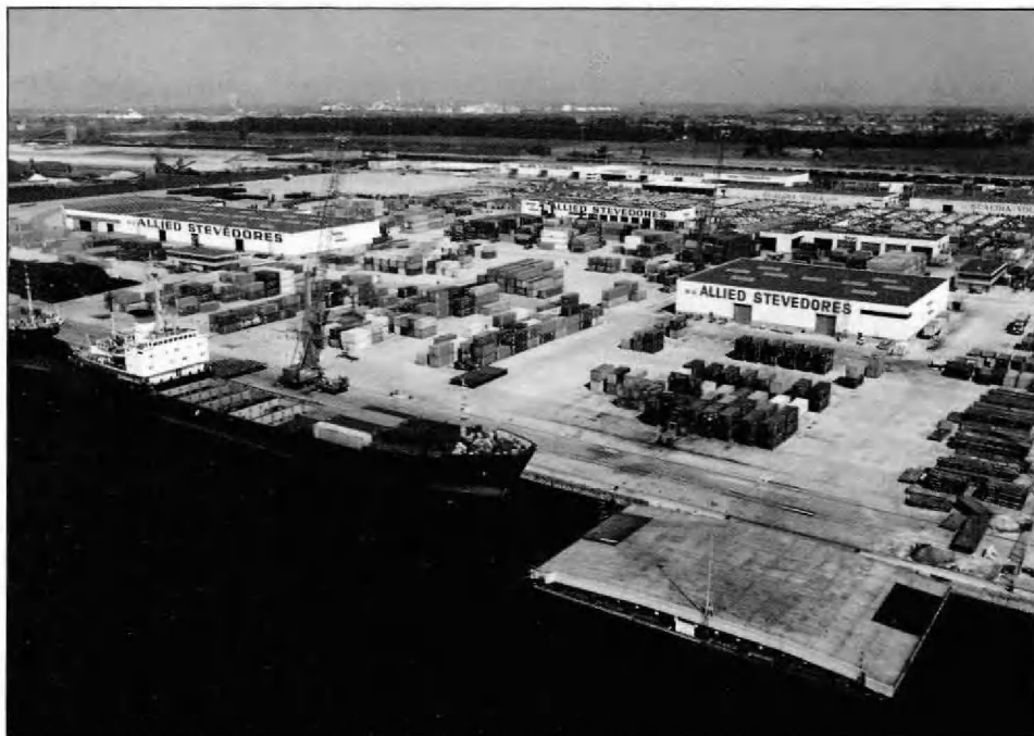
Boven: de terminal van Allied Stevedores aan het Delwaaidok. Hiernaast: Antwerp Combined Terminals beschikt aan het Churchildok over een terminal met 600 m kaailengte.
