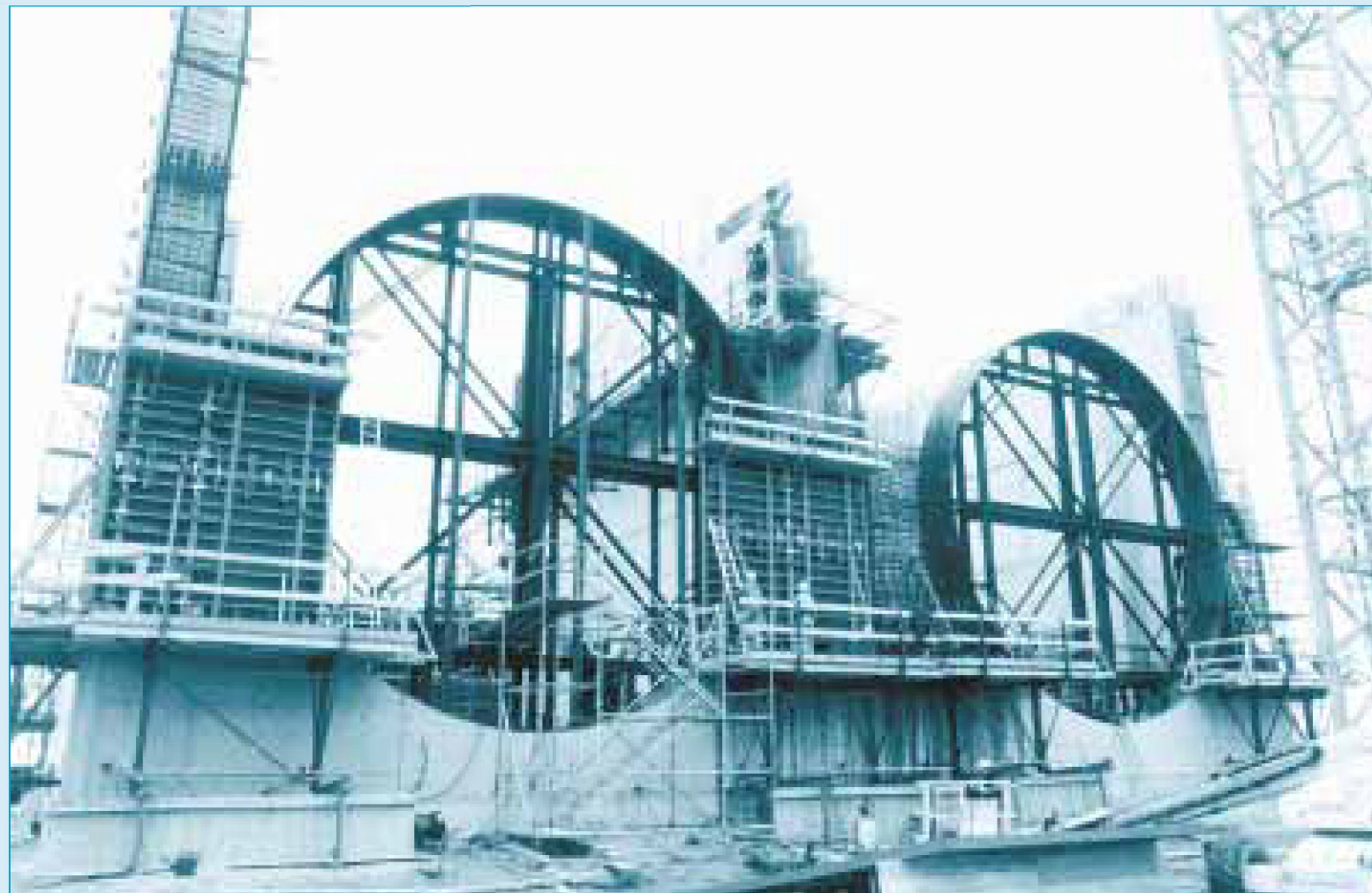
De in grote delen gedemonteerde TBM's
