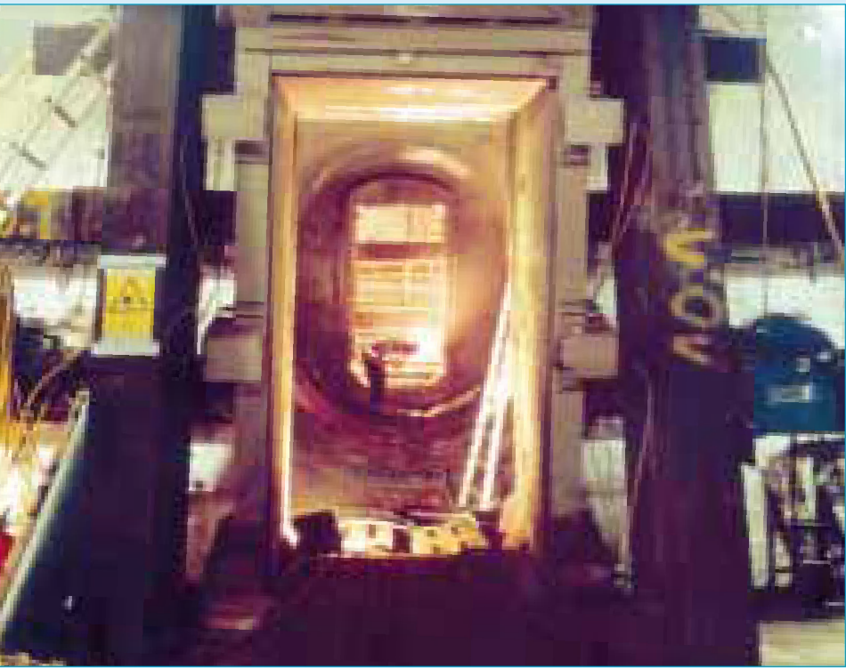
Een uitgegraven dwarsverbinding
