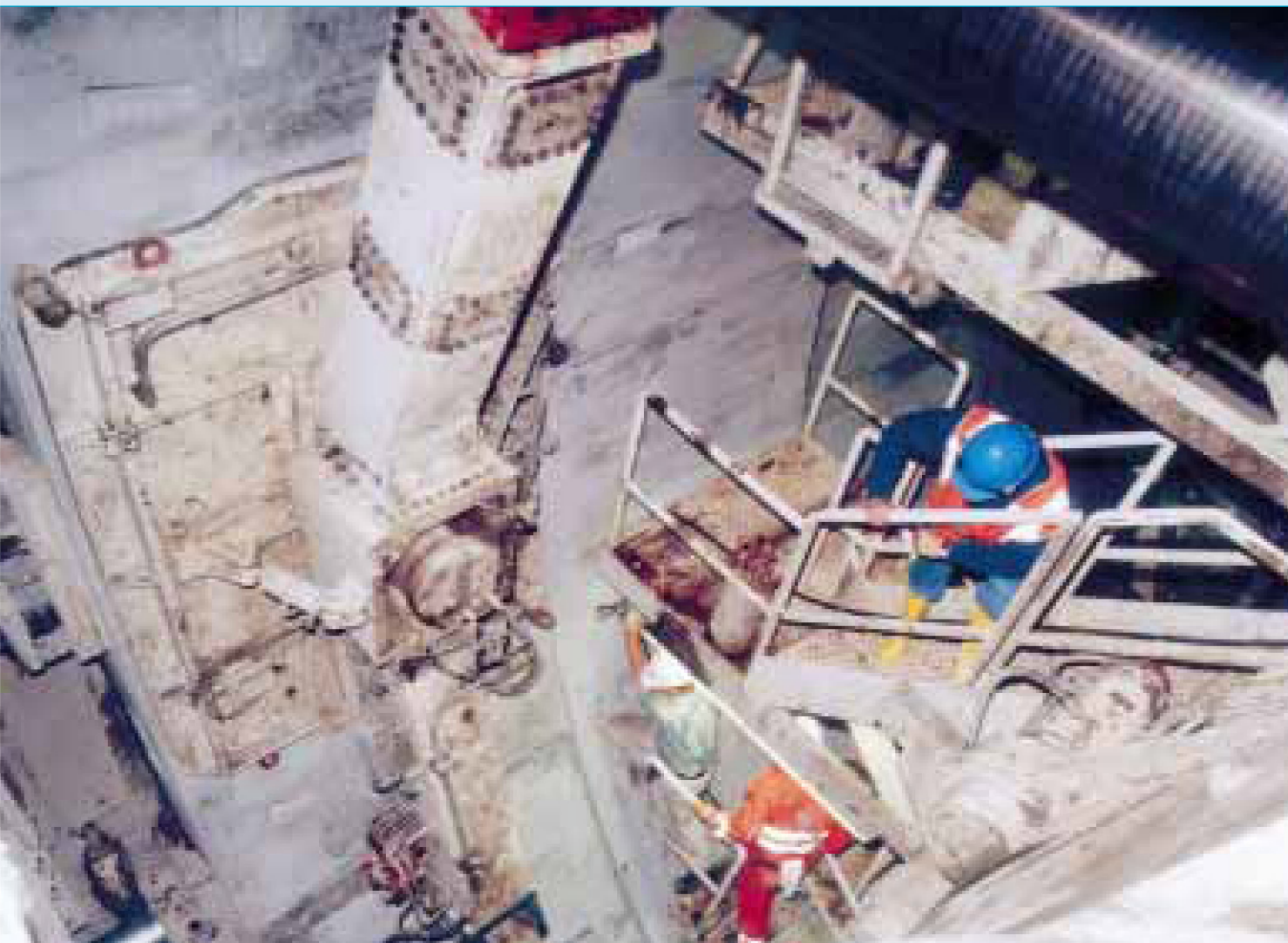
De erector plaatst een tunnelsegment
