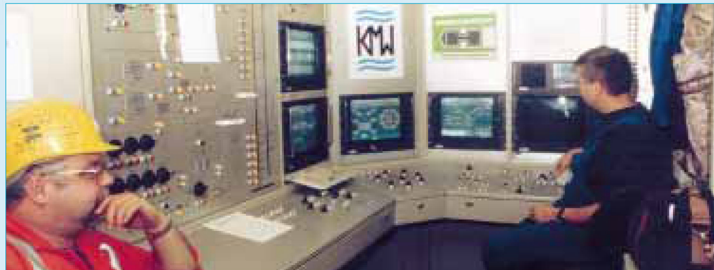
De besturingscabine in de TBM
