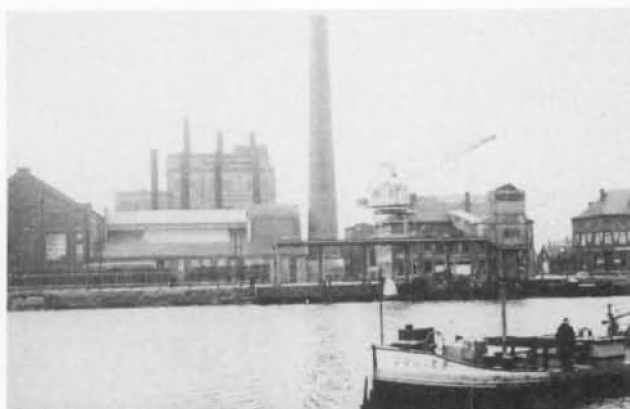
De elektriciteitscentrale van Sas-Slijkens
