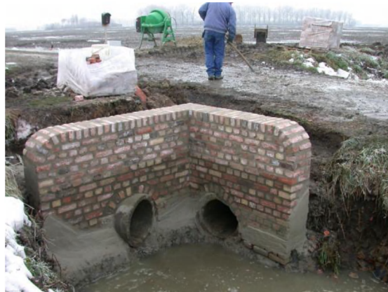
Herstelling duikers Rustoordstraat
