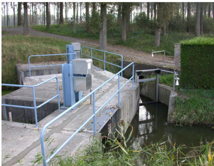
De geautomatiseerde klepstuwen op de Romboutswerveader en de Reygaertsbeek
