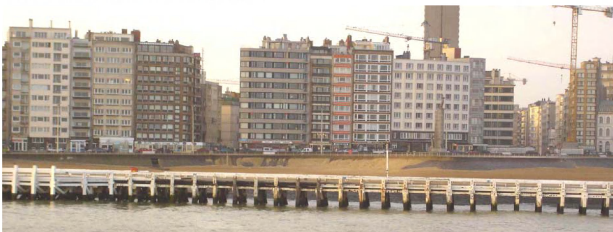
Westerstaketsel ter hoogte van het Kleine Strand
