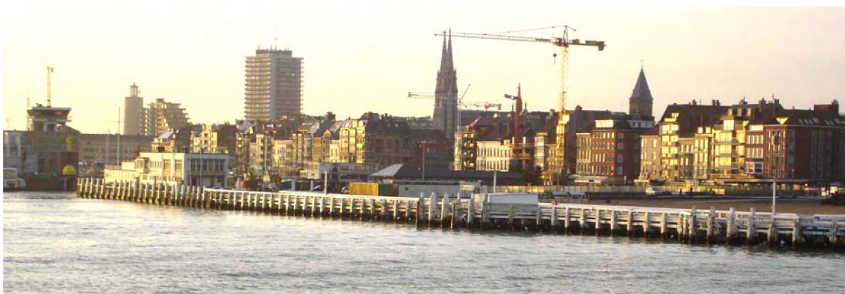
Westerstaketsel aansluitend aan het Montgomerydok
