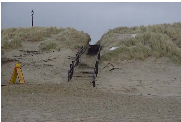
Figuur 7.4 Niet toegankelijke strandopgang Joossesweg, Zoutelande
