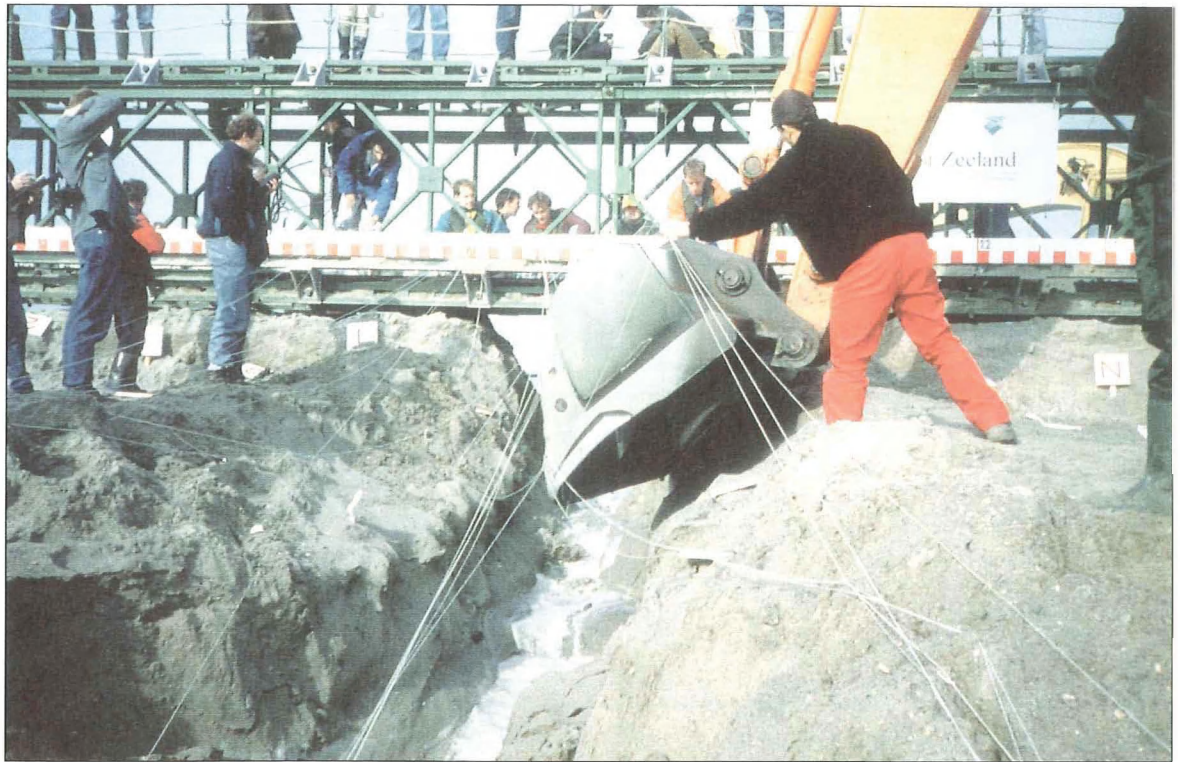
Figuur 12 Initiële geul wordt alsnog verdiept
