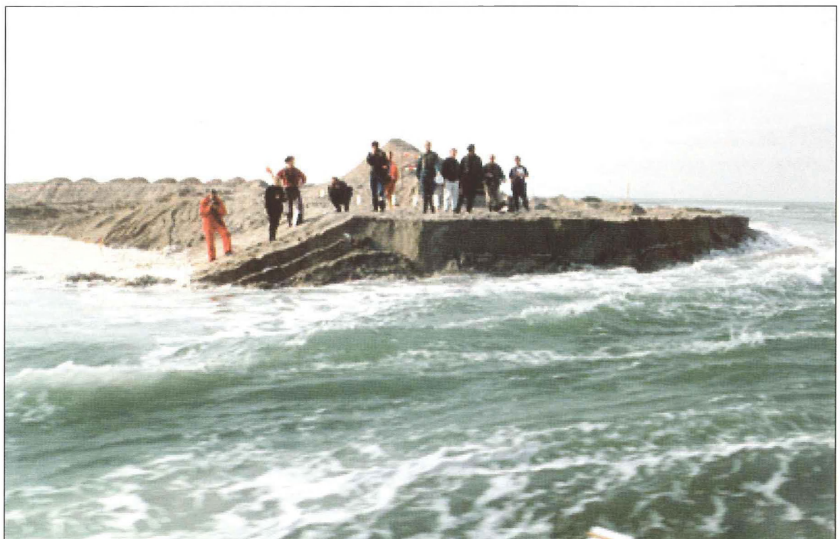
Figuur 6 Gestuwde afvoer door de bres
