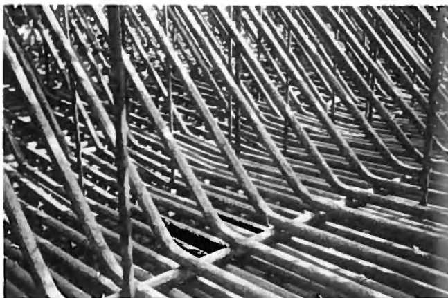
Figuur 7. Onderwapening pijlervloer, staven \varnothing 50 mm.
