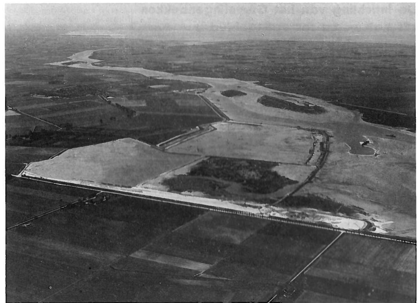
Figuur 77A. Op deze foto, genomen van noord naar zuid zijn in het midden te zien de aanleg van de oostelijke oprit met werkplateau voor de bouw van de brug ten zuiden van de Slaakdam, alsmede de aanleg van de speeldepôts I en II (zie ook fig. 64).
