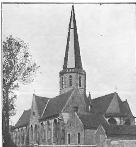
Westkapelle. Kerk van zuid-oosten gezien, na de herstelling (1907-1908).
