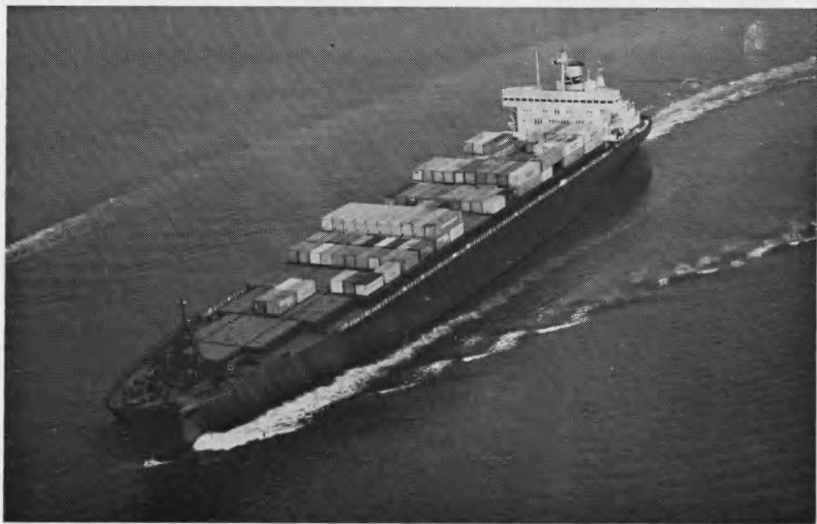
m.s. DART EUROPE. Containerschip. Draagvermogen : 22.800 ton (1.556 containers). Lengte : 232 m. Snelheid : 23 knopen.
