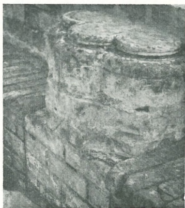
Basement van een pijlerbundel in de zuidbeuk.
