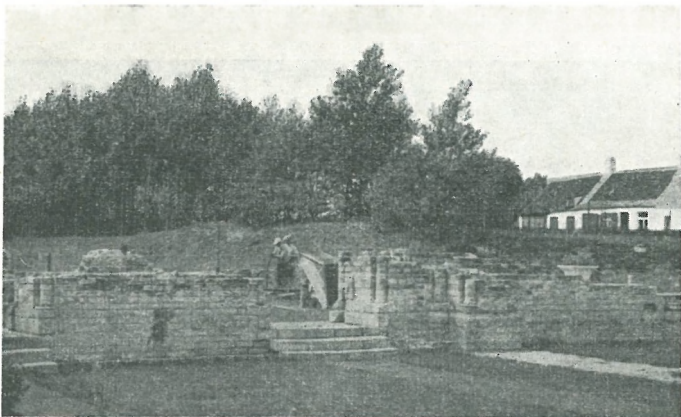
Binnenzijde van de westmuur van de kerk.
