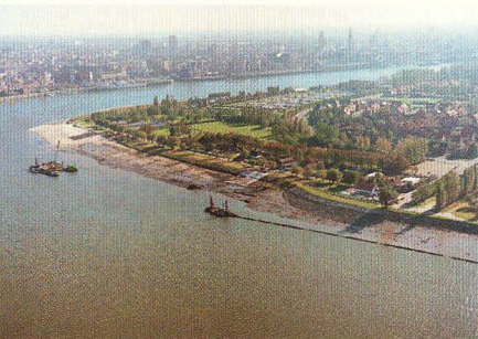
Zand uit de onderhoudsbaggerwerken t.b.v. dijkophogingen, zandlevering en strandrenovaties
