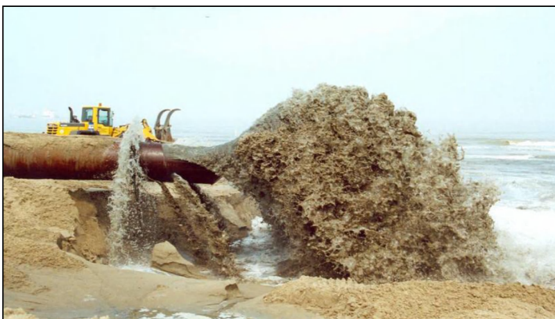
Foto: opspuiten strand De Haan
