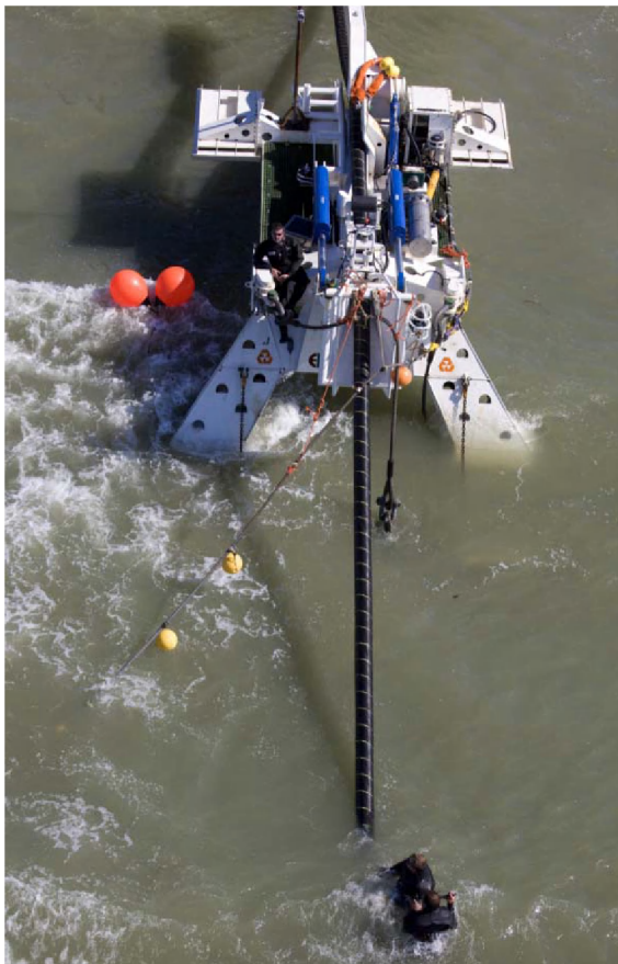
Figuur 10.2: Kabelploeg
