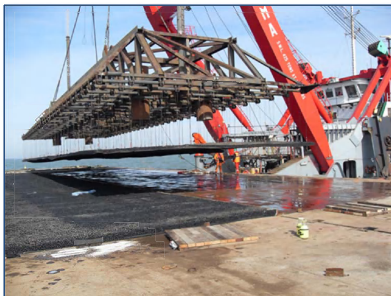
Figuur 8.3: Nauwkeurige plaatsing (in overlap tussen opeenvolgende matten) met kraanschip (toleranties < 20 cm)
