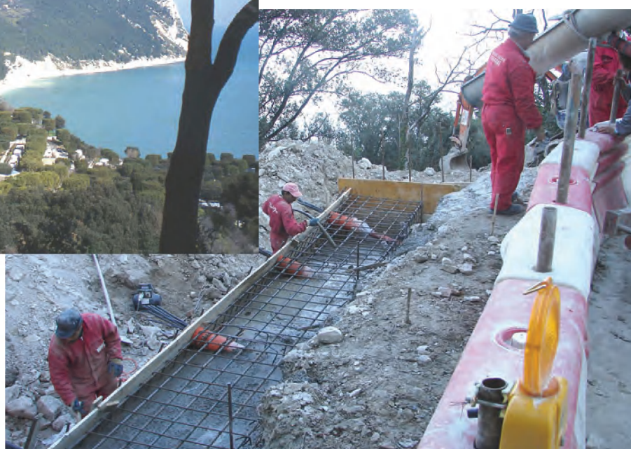
Planche 2.4: Mesures de stabilisation du glissement de terrain y compris des ancrages au sol aident à réduire les risques des déclivités vers la mer en dessous de la ville historique de Sirolo dans la Région Marche en Italie.
