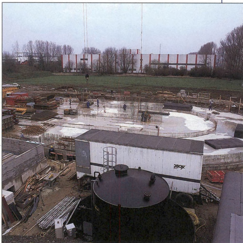
RWZI IN AANBOUW - TIENEN
